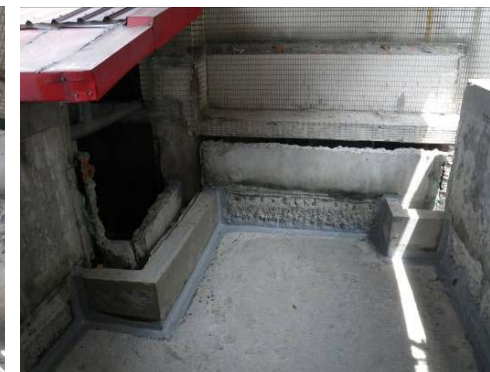
新設墩座及原防水層搭接
